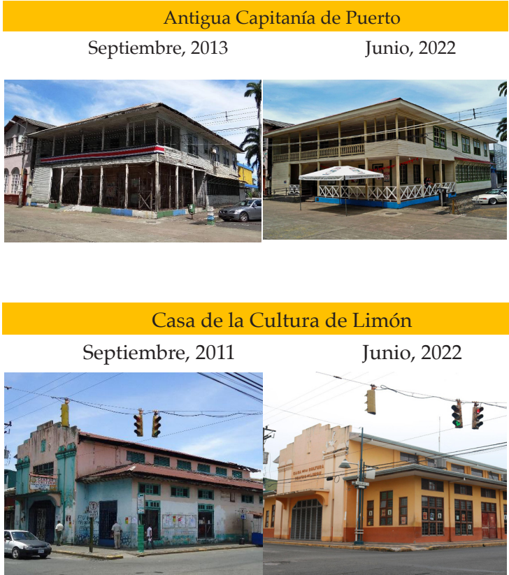
Figura 3. Procesos de restauración de inmuebles públicos con declaratoria de PHA
